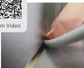
Fuge mit passender Rundschnur hinterfüllen
