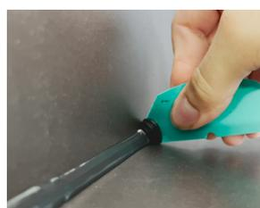
Dichtstoff abgeglättet (Glättmittel nicht mit einer Sprühflasche auftragen)
